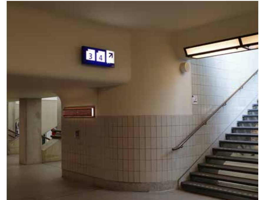
Perrontunnel in station Eindhoven; de aansluitingen van plafond op wand, maar ook van wand op wand, zijn gekromd
