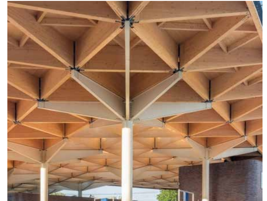
Gecombineerde constructie van hout en staal
