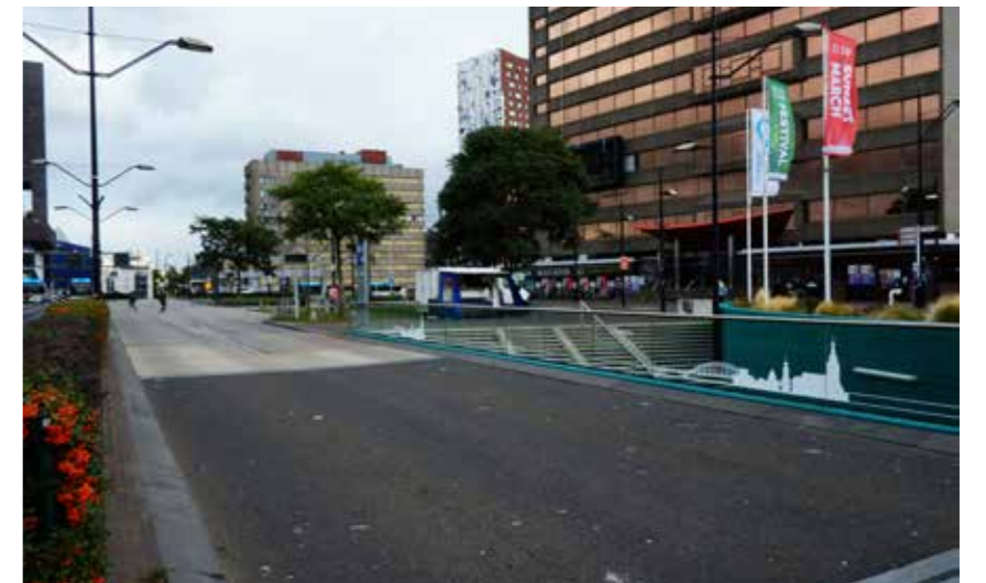
Busbaan tussen stationsplein en Metterswane met rechts de entree naar de ondergrondse fietsenkelder
