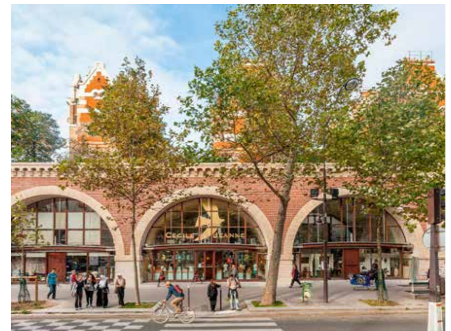
Viaduc Daumesnil, Parijs: eenduidigheid van de gevel
