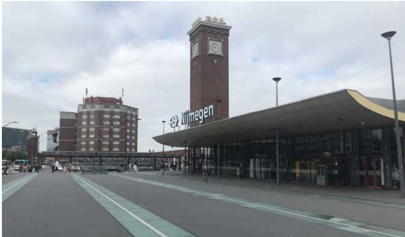
De huidige luifel en stationshal hebben geen relatie met de gevel van Van Ravesteyn
