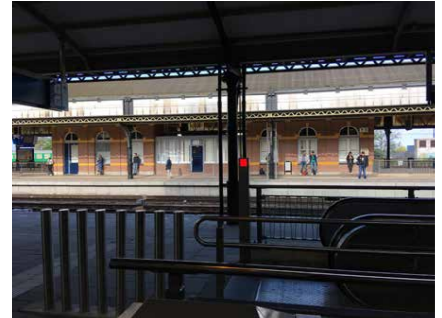
Zicht op de wachtruimtes vanaf het Perronplein
