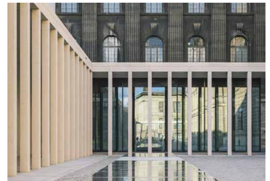
JS-Galerie, Berlijn; harmonie in ritme tussen oudbouw en nieuwbouw
