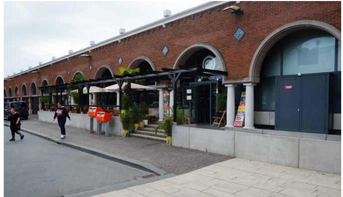
Houten constructie tegen de gevel waardoor de boogvormen niet goed zichtbaar meer zijn
