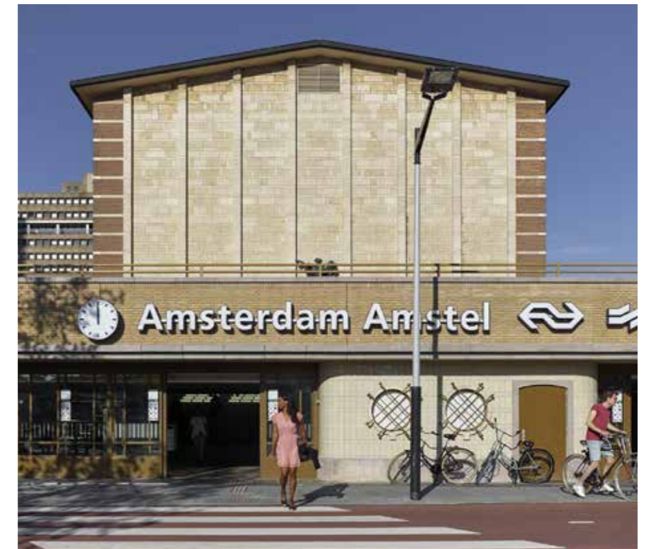
Entree station Amstel; de toegang ligt terug t.o.v. de rooilijn
