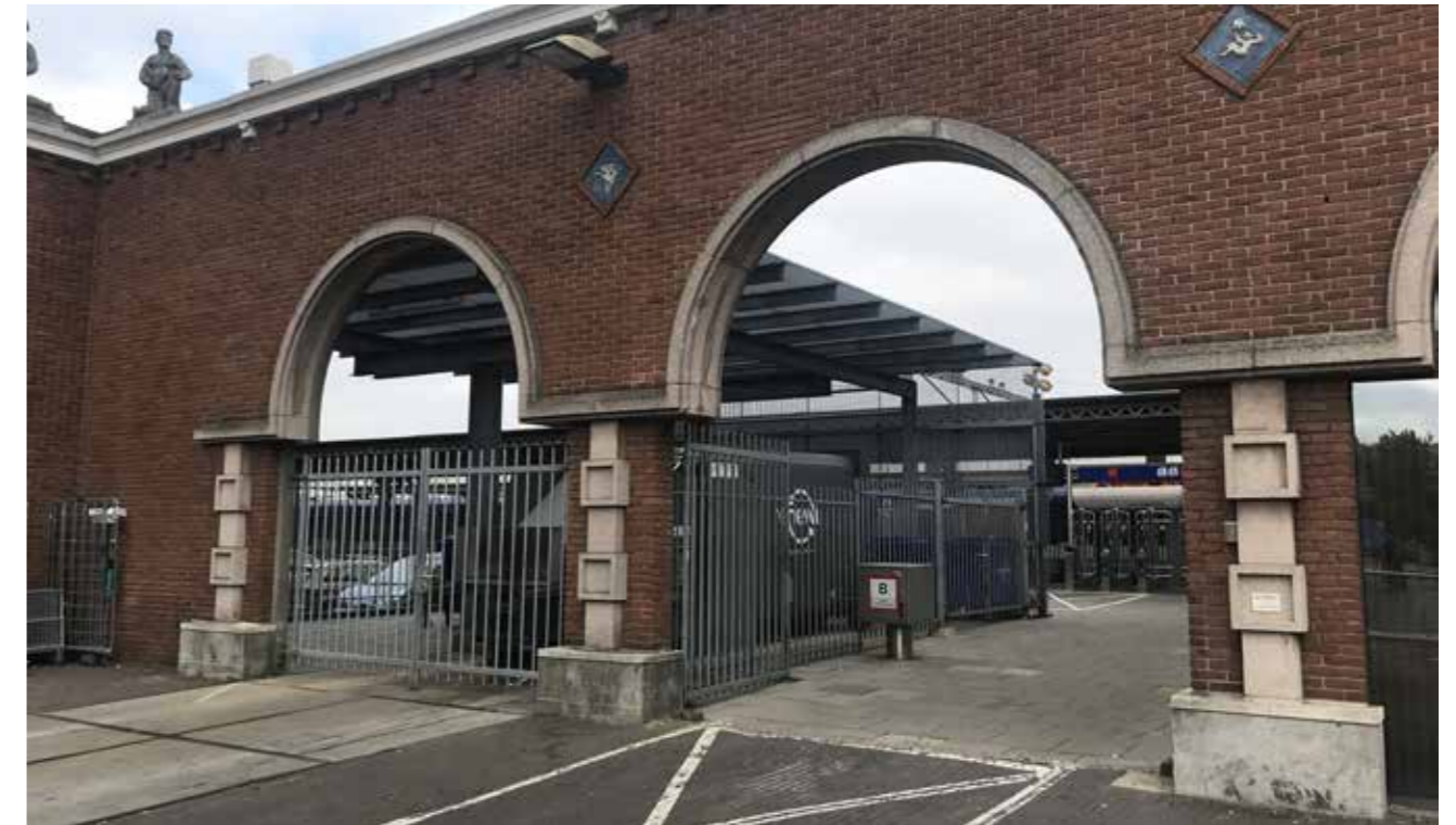
Afvalcontainer bij de secundaire entree aan de zuidzijde
