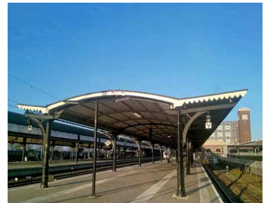
Perronkap Spoor 35 wordt versmald i.v.m. elektrificatie Maaslijn
