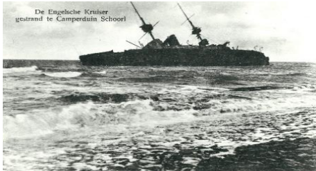
Stranding van het afgedankte slagschip HMS Prince George in 1921 op stroomhoofd 24 van de Hondsbossche Zeewering
