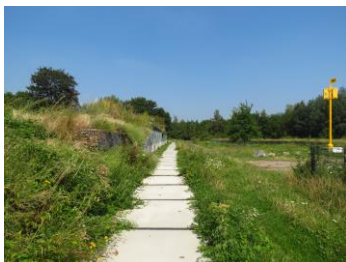
Het betonpad volgt een van de vroegere rangeersporen. De verhoogde ligging is ideaal voor de muurhagedis.
